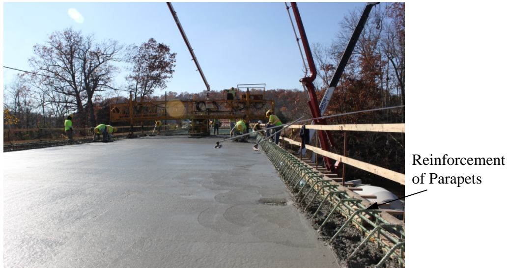
Figure 3-5 Pour of B0439 Deck
